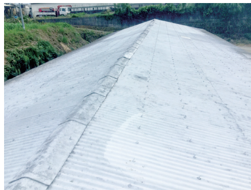
写真1 石灰塗布後の屋根
