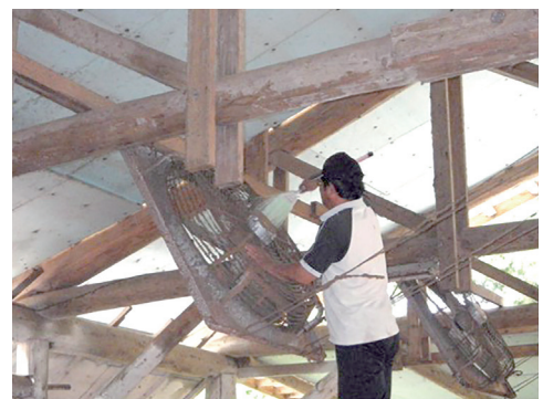
写真2 牛舎内の換気扇の清掃
