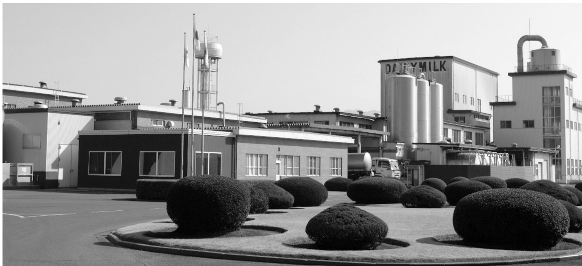
都城工場外観
